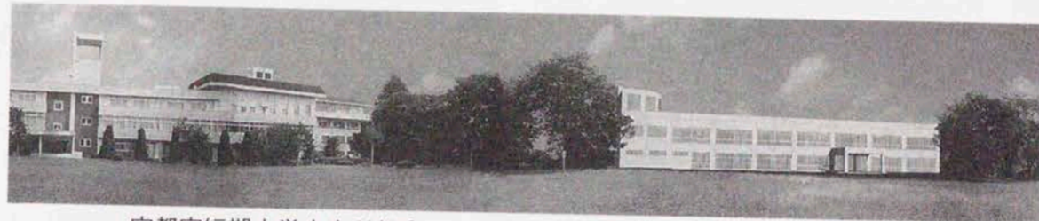
図書館・学生ホール（建築中）
